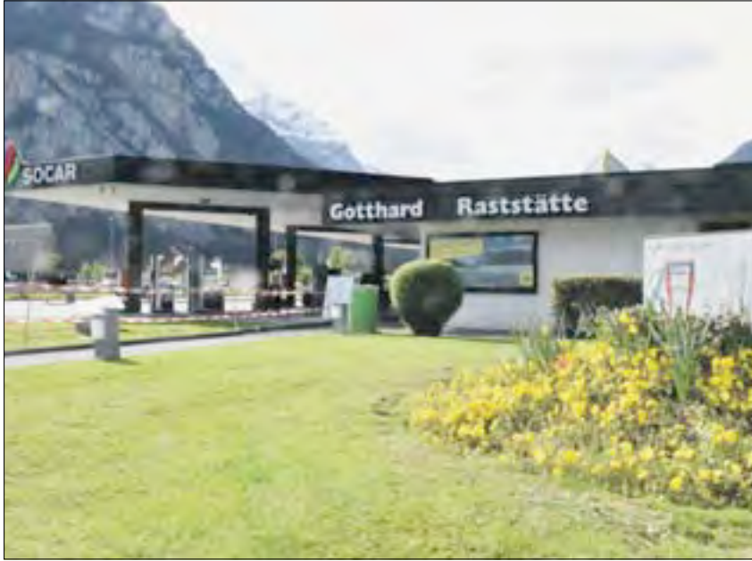
Das Gebäude Fahrtrichtung Süd der Gotthard-Raststätte gehört bald der Vergangenheit an: Es wird komplett neu gebaut. FOTO: ARMIN STALDER
