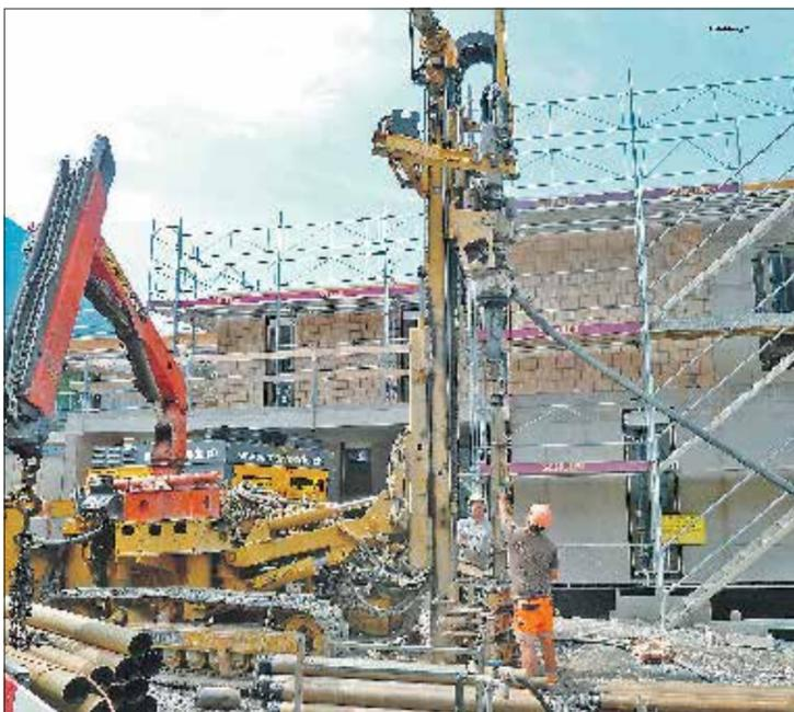
Die Nachfrage nach Erdwärmesonden und Grundwasserwärmepumpen ist hoch. Im Bild ist eine Bohrung für eine Erdwärmennutzung im Urner Talboden zu sehen. FOTO: ZVG
