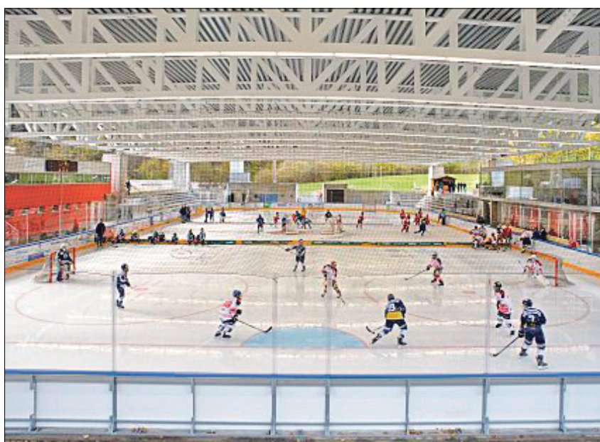
Die Eishalle von Faido wurde Ende Oktober eröffnet. Die Überdachung kostete 1 Million Franken mehr als budgetiert. FOTO: ZVG
